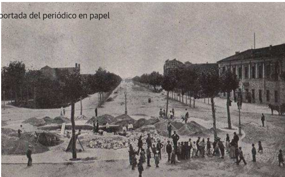
Imagen de J. Thomas que muestra los trabajos para instalar la obra. /ARCHIVO MUNICIPAL
